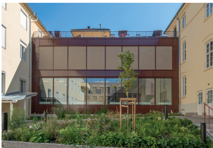
Nye glass- og aluminiumfasader vender inn mot et av prosjektets grønne pusterom.
